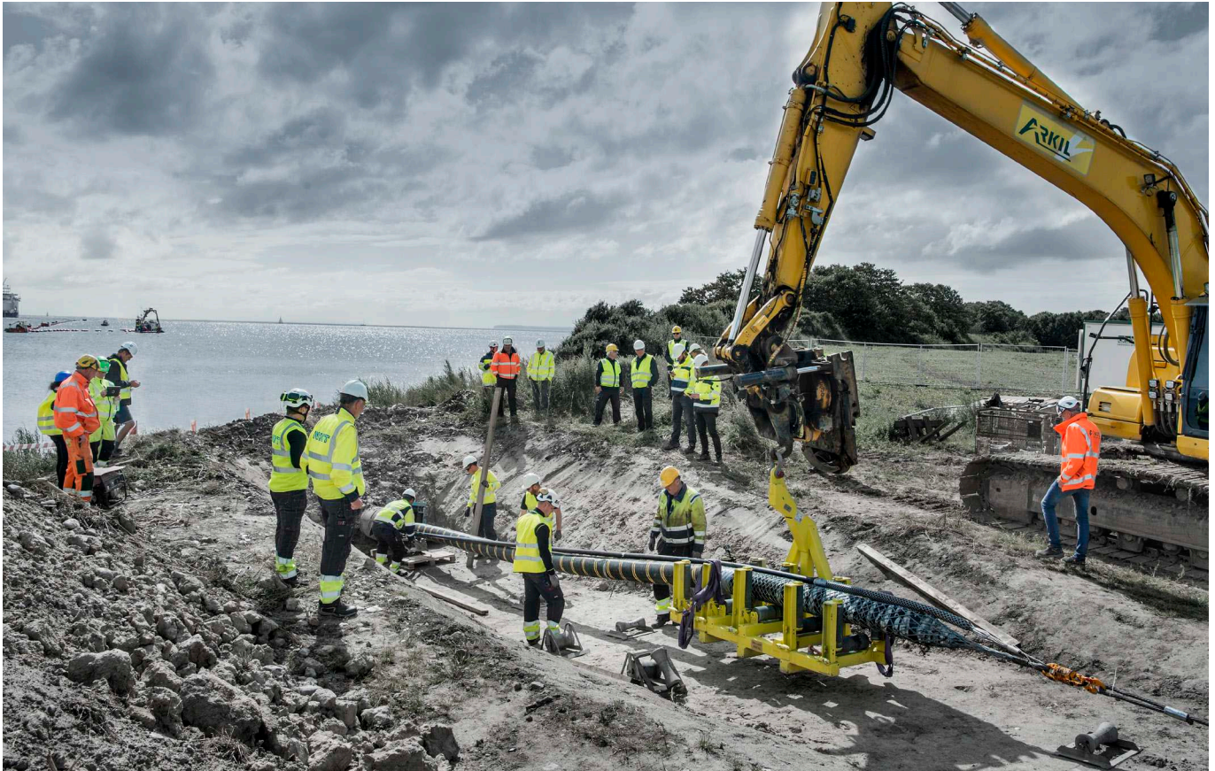
Her ilandtrækkes søkablet til det EU-støttede Kriegers Flak-projekt, der skal forbinde tyske havvindmølleparker med en kommende dansk havvindmøllepark i Østersøen.
