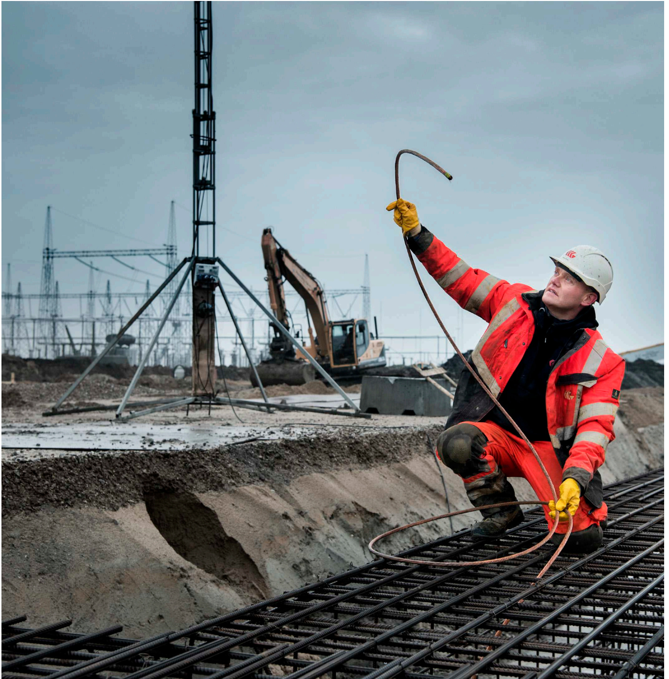
Etablering af COBRACable på station Endrup i Vestjylland.
