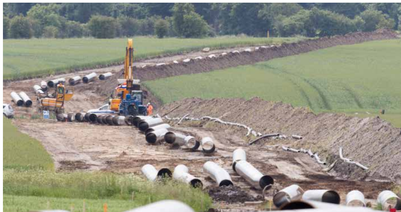
Energinet lægger gasrør i jorden mellem Ellund og Egtved i 2012. Den ekstra gasforbindelse til Tyskland skabte bedre forsyningsikkerhed i Danmark. Det samme vil blive tilfældet for Baltic Pipe, den store gasrørledning til Polen, som i 2017 kom væsentlige skridt tættere på realisering.
