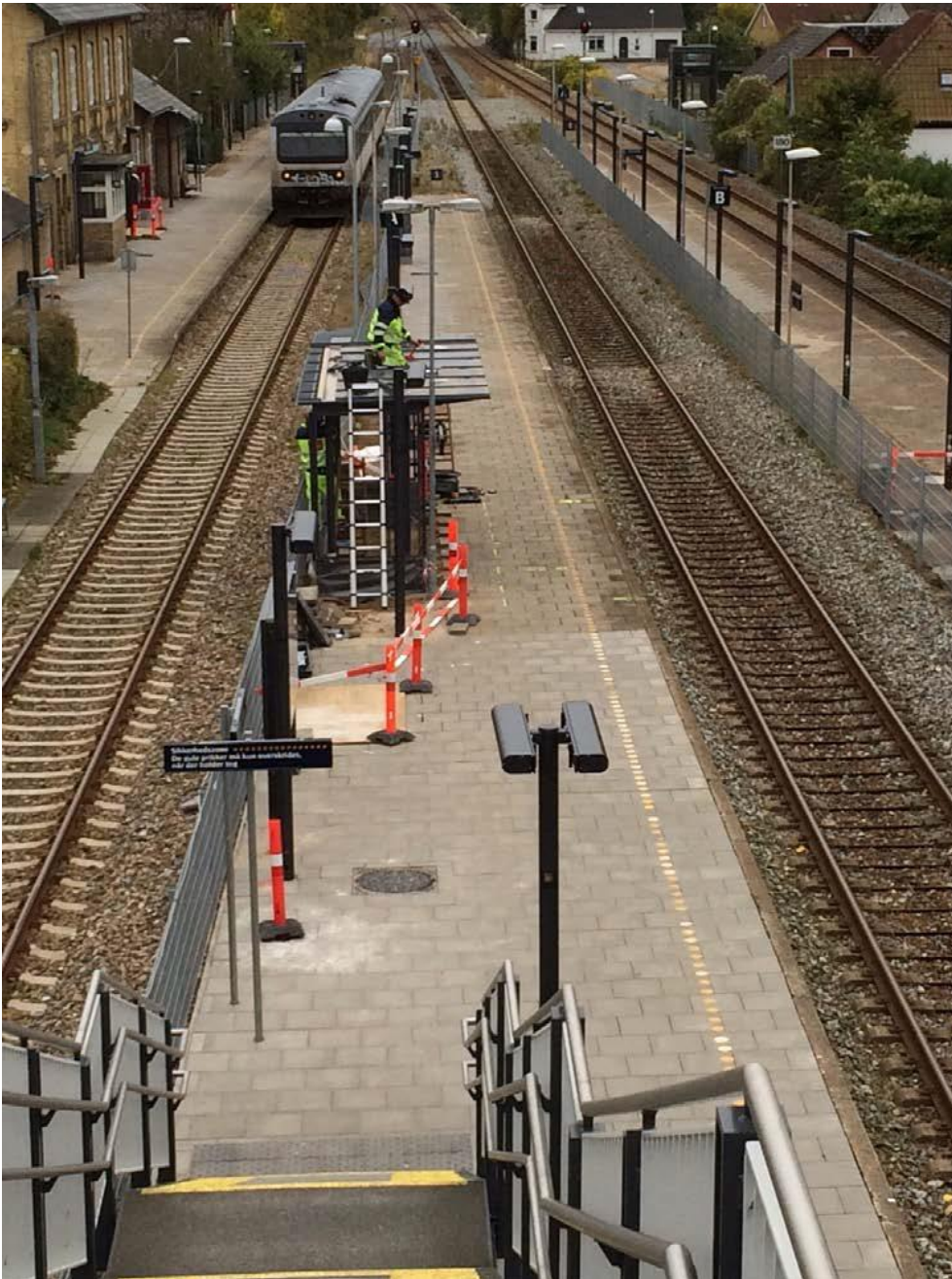
Skørping station, set fra gangbro mod syd, læskærm under opførelse. Toget i spor 1 er tog på Aalborg nærbane”.
