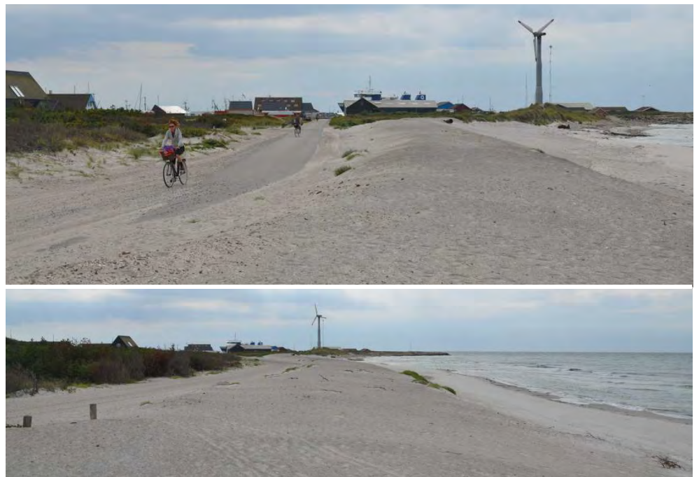
Figur 4-17 Vejen øst for Anholt Havn er i dag beskyttet af vold skabt vha. strandfodring
