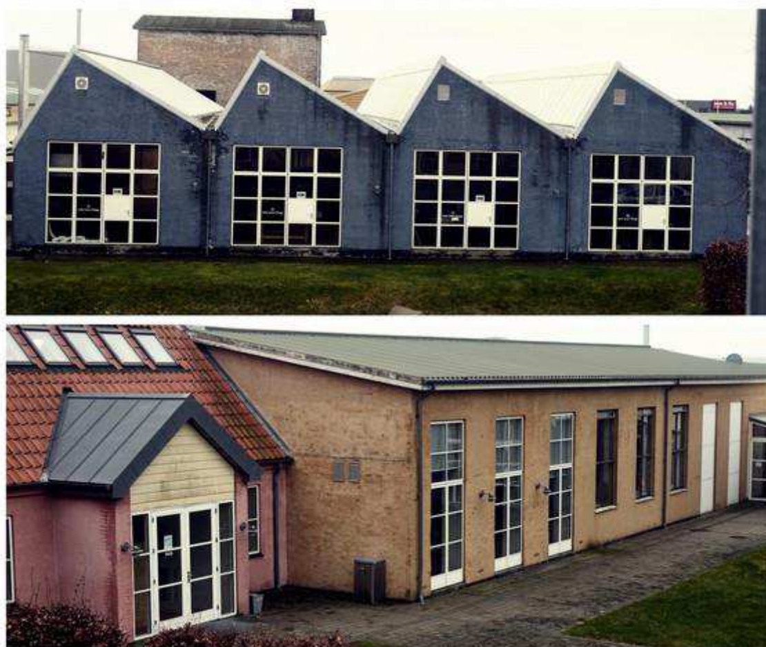
Figur 5.1: Bright Park Bornholm i den renoverede møbelfabrik (Foto: Jens Kaae Fisker)
