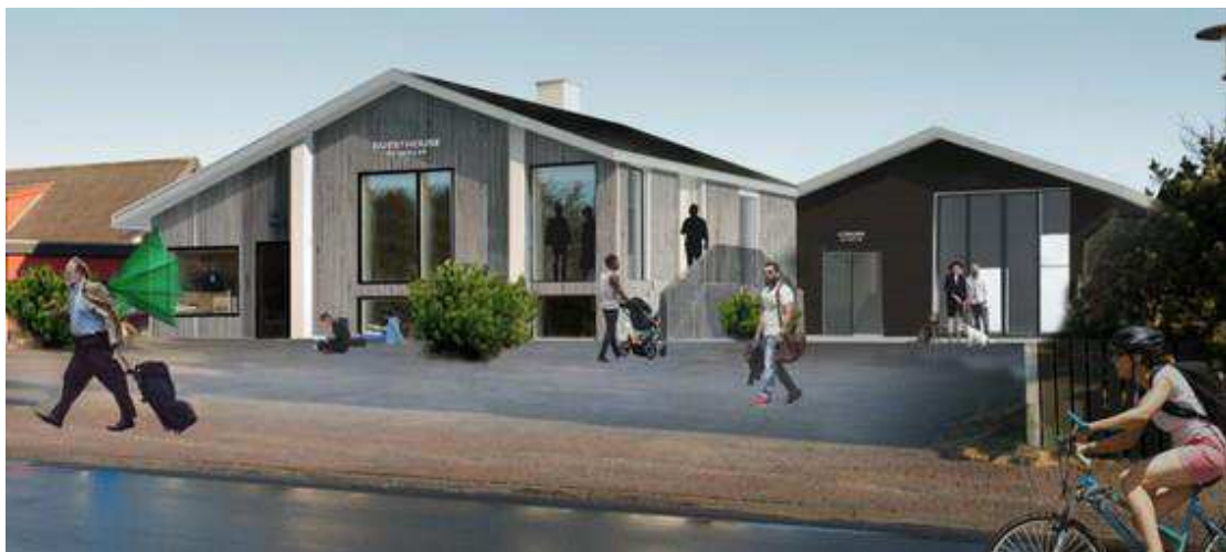
Figur 4.2: Cowork Klitmøllers fremtidige udseende efter ombygning i 2016-17 (Illustration: Cowork Klitmøller, 2016)
