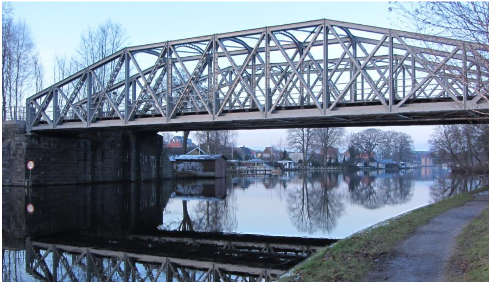
Figur 33. Fredede broer over Remstrup Å ved Silkeborg
