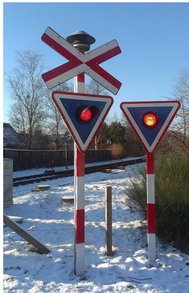
Figur 34. Signaler ved overkørsel ved Svejbæk station
