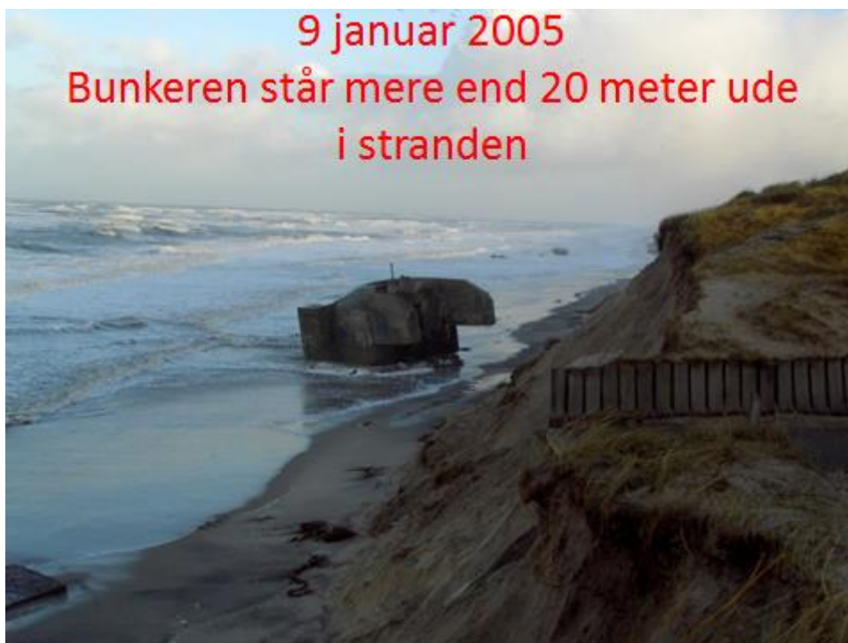
D. 9. januar 2005 stod bunkeren 22 meter ude på stranden og havet havde taget 8 x 22 x 1000 176.000 kubikmeter af klitterne efter den mislykkede sandfodring.
