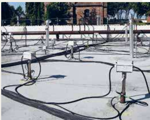
Lange 'dypkogere' placeret i den forurenede jord. Dypkogere varmer jorden op og koger forureningen væk.
