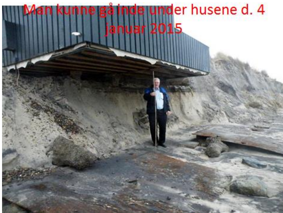
Her står jeg inde under huset d. 4 januar 2015 med en 2 meter lang tommestok
