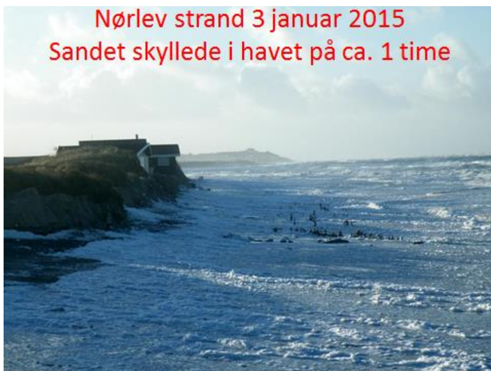
Sandfodringen skyllede i havet på 1 time d. 3 januar 2015
