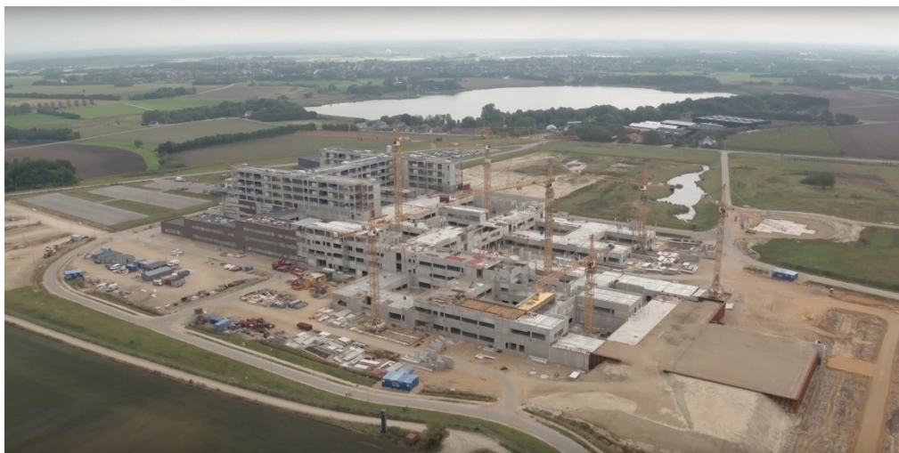
Luftfoto af DNV-Gødstrup-byggepladsen i september 2016. Bagerst ses etape 1, der er den mest fremskredne. I forgrunden ses etape 3.
