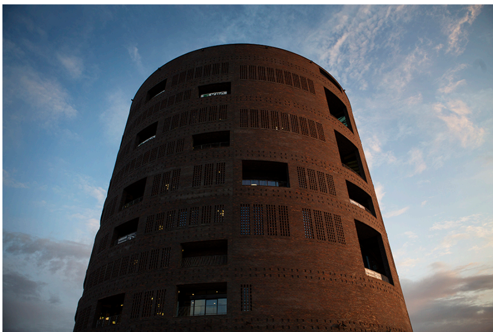
Et af Banedanmarks 2 nye trafikkontrolcentre.
