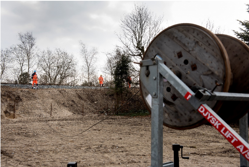
Arbejde ved sporstrækning i forbindelse med Signalprogrammet.
