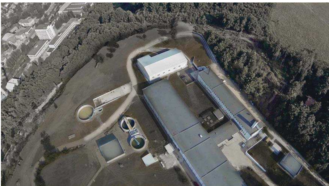
Foto 4 - Vandbehandlingsanlæg i Gabrovo (Bulgarien)
