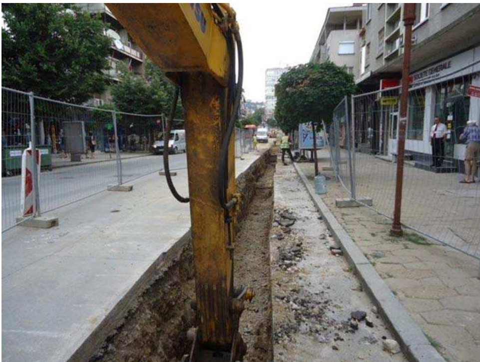
Foto 3 - Udgravningsarbejde i Veliko Tarnovo (Bulgarien)
