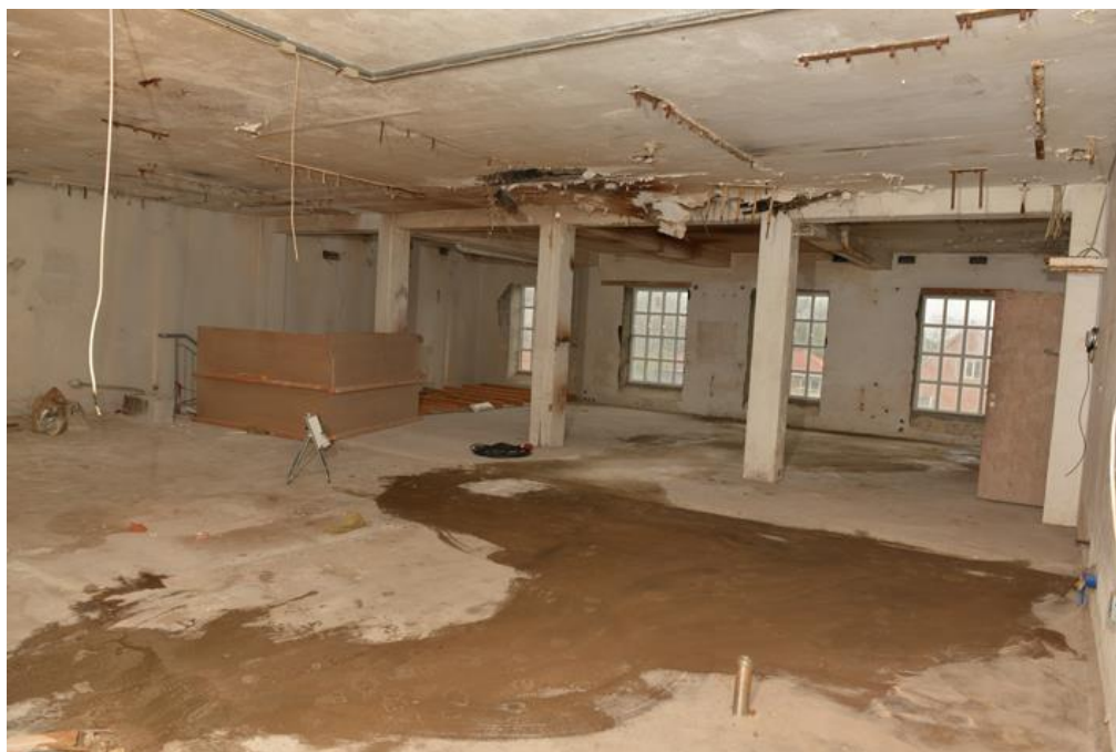
1. sal, hvor der tænkes etableret kontorlokaler og foto atelier Foto: Bjarne Ingemann
