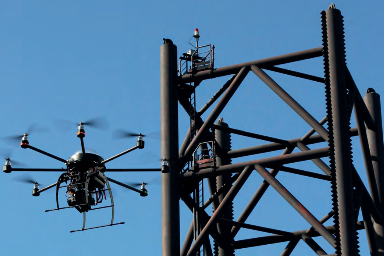
Inspektion med droneteknologi er en omkostningsbevidst og effektiv inspektionsmetode i højden og på svært tilgængelige områder. Foto: FORCE Technology
