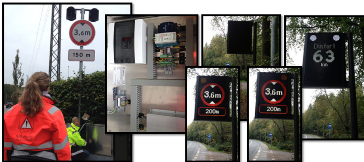
Figur 16. En af problemlokaliteterne var plaget af, at specielt udenlandske chauffører overså den almindelige stationære skiltning, med advarsel om lav bro. Her blev det derfor valgt at opsætte en variabel tavle, der kun aktiveres, når et køretøj over den tilladte højde passerer. Her henvises de til en vendeplads inden broen. For at registrere effekten er opsat en ekstra flytbar højdemåler, der lige som den første variable tavle logger alle hændelser i kommunens signalovervågningssystem. Herved kan Silkeborg let og overskueligt vurdere om den 1. variable tavle har den ønskede effekt, så den 2. tavle kan flyttes til en anden lokalitet i Silkeborg. Den variable tavle kan ligeledes anvendes som "Din fart"-viser, når advarslen om lav bro ikke er aktiveret.
