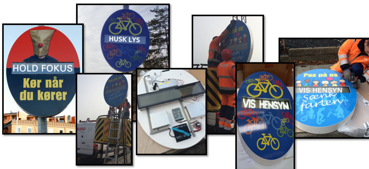
Figur 17. Silkeborg udviklede desuden en ny type vejkantplakat med display. Der blev udviklet 3 forskellige frontplader, der kan udskiftes efter behov og lokalitet. De 3 frontplader blev målrettet henholdsvis cyklister, kørende og veje med mange gående. Tavlen opsættes på en belysningsmast, og trækker strøm fra denne til displayet. Via kommunens signalovervågningssystem kan teksten og tidsrum for tekstvalg ændres løbende og efter behov. Lokalråd, skoler og borgere kan ønske opsætning af skiltene på fx skoleveje.
