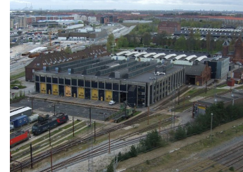
Vedligeholdelsen kan ske på eksisterende værksted med DSB personale, der udfører vedligehold efter leverandørens anvisninger og på leverandørens ansvar
