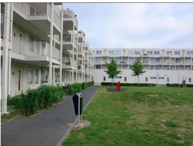
Den midterste karré set mod nord. Virksomhederne i bunden bag i billedet vender på den anden side ud mod Europalaan. Alle øvre etager på dette billede har altangangsadgang. Der er dog udepladser der.
