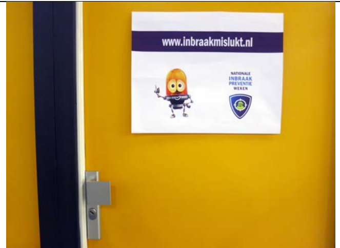
En officiel person fik til opgave at forsøge at bryde ned 4 døre op. Det gik nemt undtagen på denne dør, der lever op til nutidig PKVW standard. Bemærk sikring mod cylindertræk på låsebeslaget.
