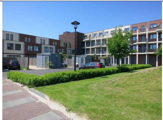
Vestligste karré. Her er et legeområde på en bakke i nordøst. Altangangsadgang ovenpå virksomhederne (til højre i billedet). Flere af rækkehushaverne er fortsat åbne, uden hegn og låger.
