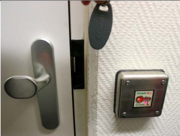
Elektronisk lås til dør til opbevaringsområdet (samme dør som på øverste højre billede). Den elektroniske nøgle ses øverst i billedet.
