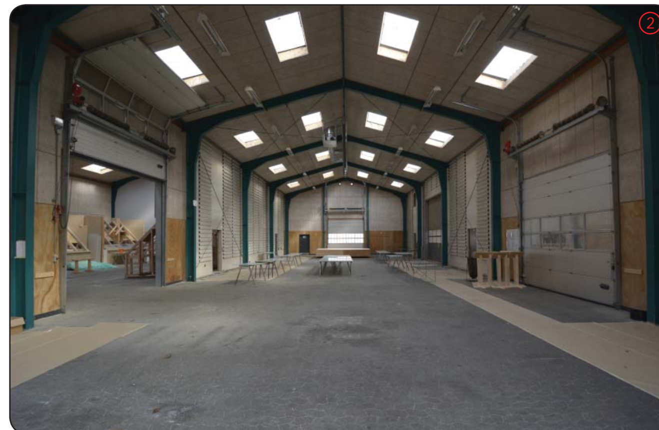
Store opvarmede haller med fleksible indretningsmuligheder
