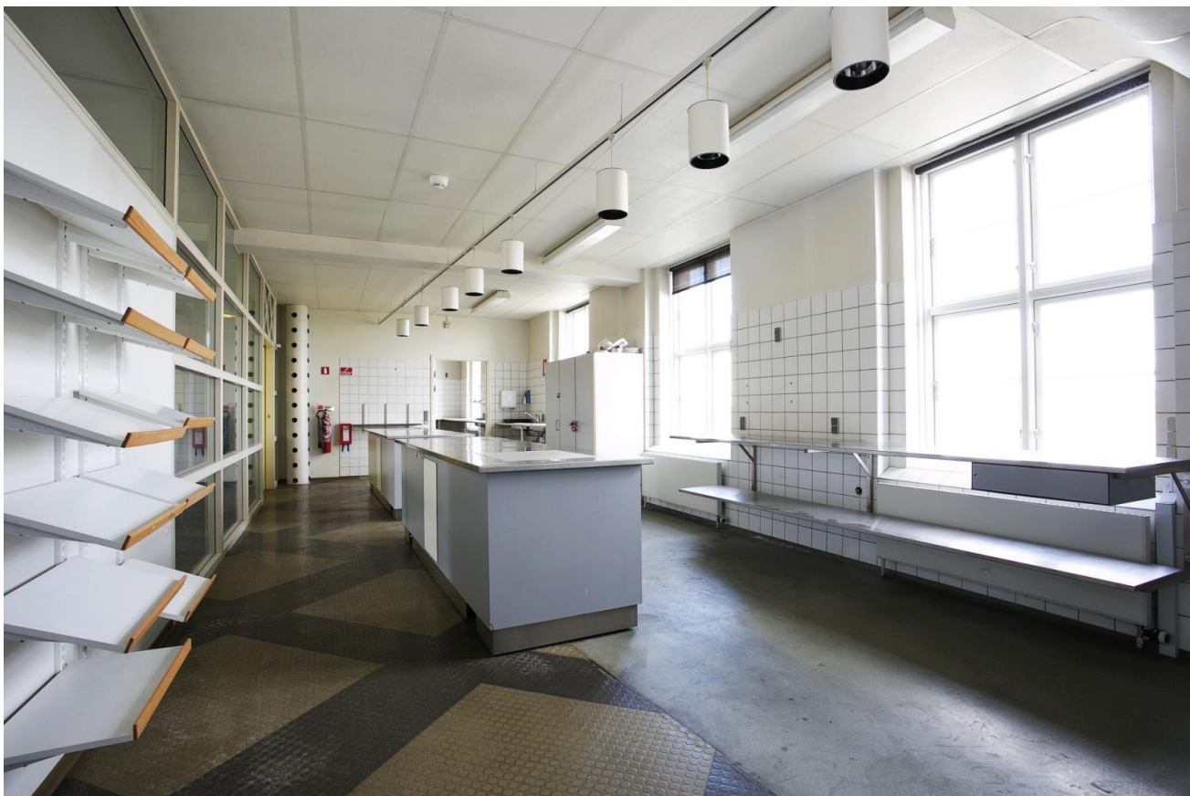
8 Køkkenfaciliteter i østfløjen (industrikøkken er pakket ned i tilstødende lokaler pt.)
