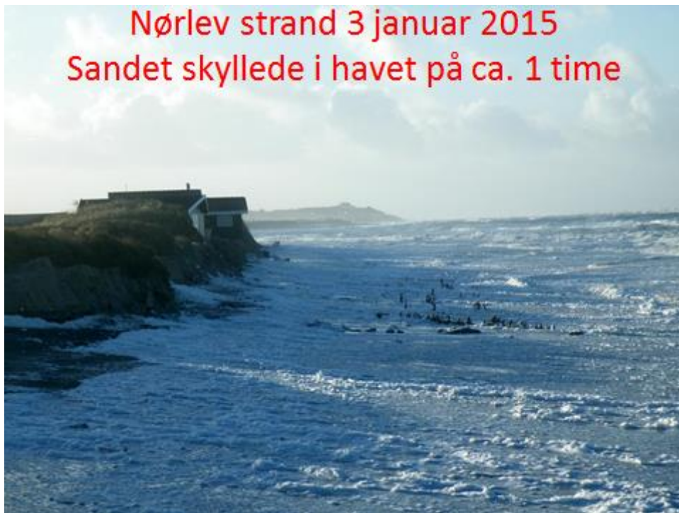
Sandfodringen skyllede i havet på en time d. 3 januar 2015
