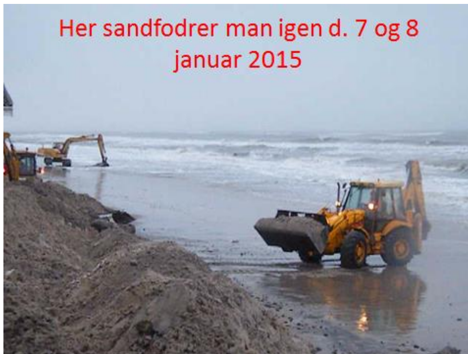
Da der ikke er mere sand i Hirtshals graver man bare i stranden med tre maskiner d. 7 og 8 januar 2015
