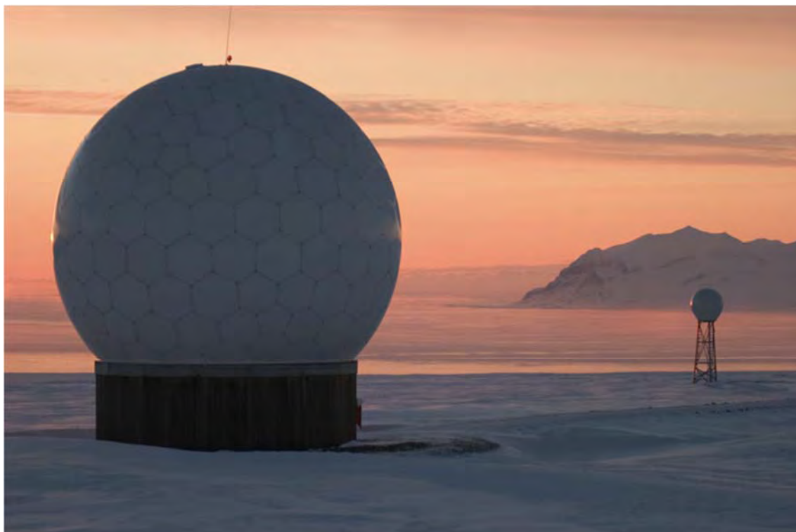
SvalSat - Svalbard Satellite Station. Foto: ESA
