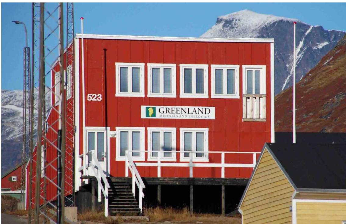
GMI's kontorbygning i Narsaq, 5. oktober 2015.
