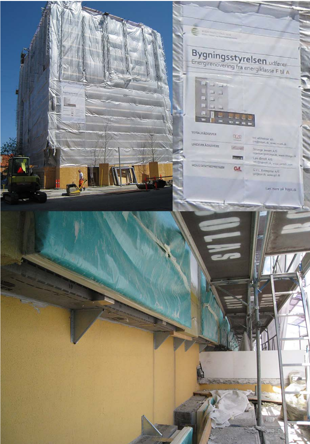
Energirenovering af Bygningstyrelsens kontorejendom fra 1938 i Vester Voldgade 123 i København. Via rentable energirenoveringer som fx efterisolering af facader rykkede styrelsen energimærket fra F til A og forventer, at energiforbruget bliver reduceret med 80 %.
