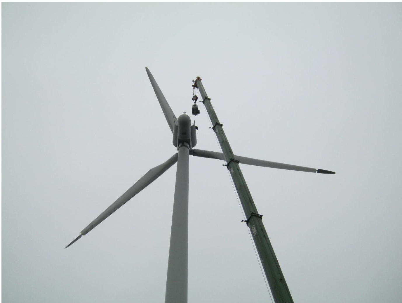
Figur 1: Udskiftning af generator mølle 6.
