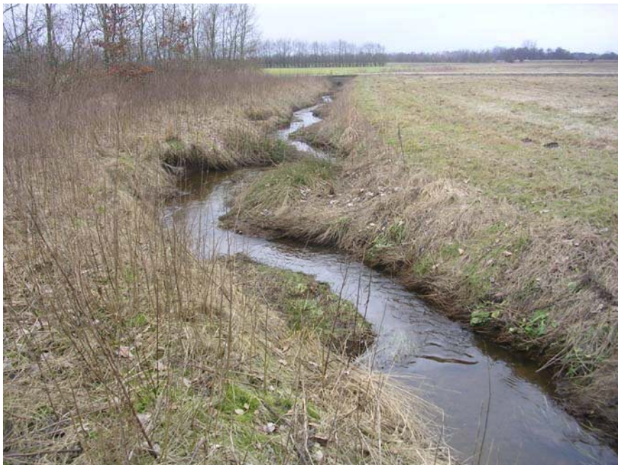
Hammerum Bæk - genslyngning ved hjælp af grødeskæring
