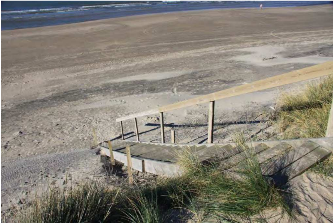
Billede 15 Trappe der er placeret imellem hus 6 og hus 7
