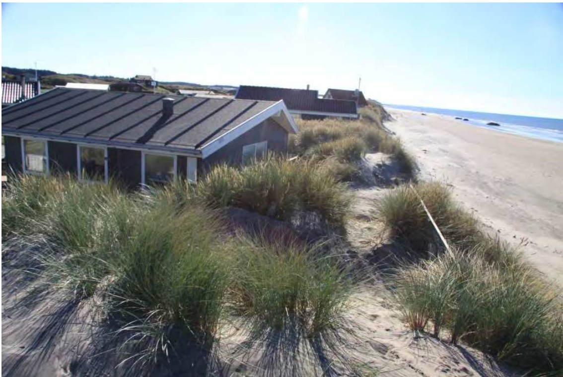
Billede 16 Hus 6 og 5 på den besigtigede taget mod syd
