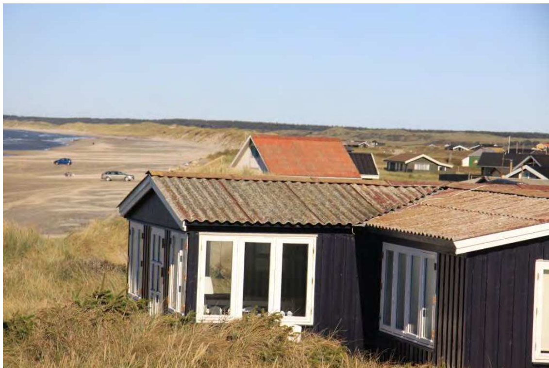
Billede 3 Sydligste hus (hus 1) på den besigtigede strækning
