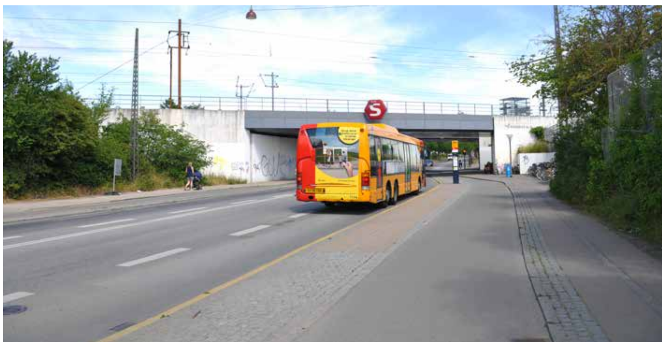
Den eksisterende jernbanebro over Vigerslev Allé.
