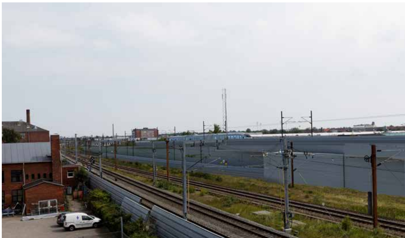
Figur 27 Punkt 2. Udsigt mod sydøst fra Kildeskolen på Høffdingsvej. De alternative støjskærme ligger som et markant visuelt element på broen og langs Den nye bane København-Ringsted. Visuelt falder støjskærmen langs Den nye bane København-Ringsted sammen med brokonstruktionen, der derfor virker mere massiv.
