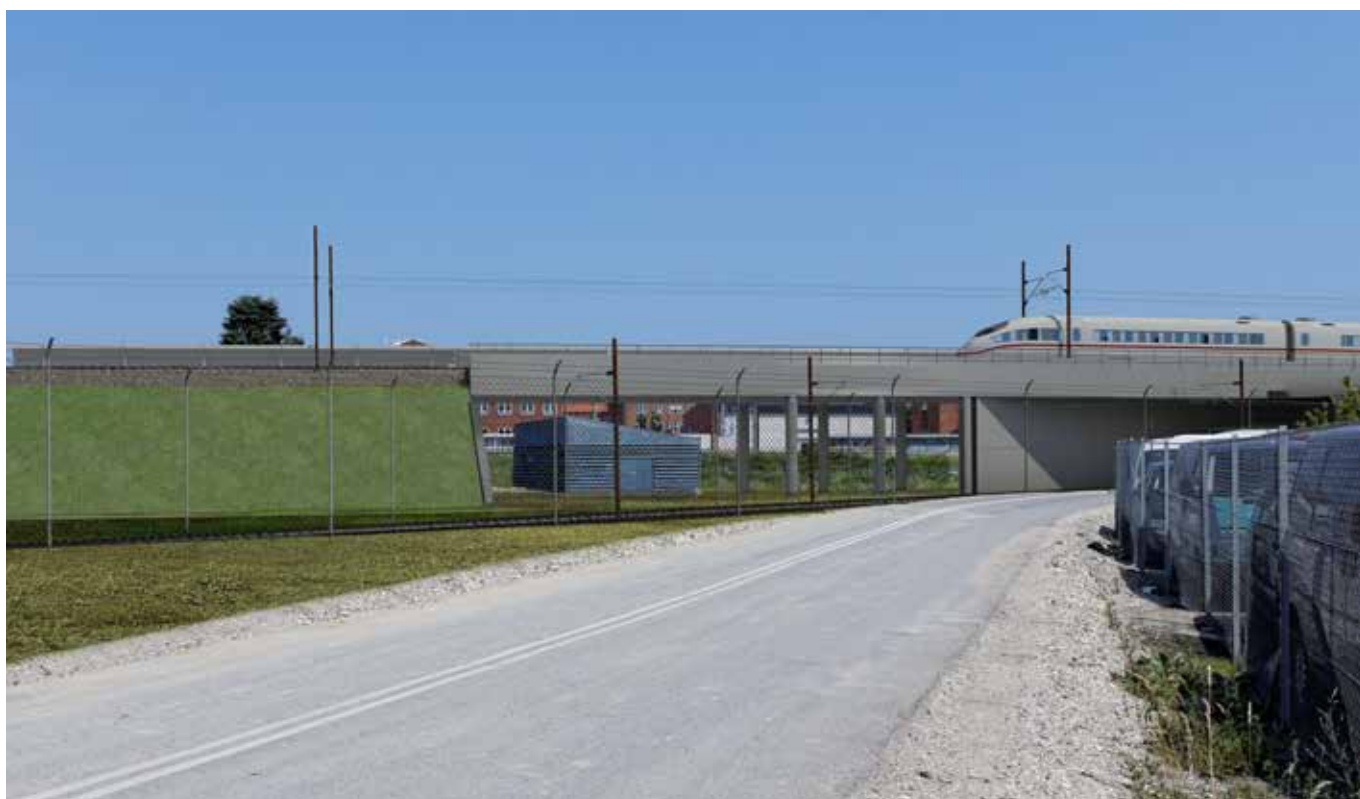
Figur 28 Punkt 3. Udsigt mod nordøst fra Retortvej. Den alternative støjskærm på den nye jernbanebro hæver højden af anlægget. Til gengæld er der en vis visuel forbindelse til nordsiden under broen, som ellers blokeres med den forhøjede støjskærm i 0-alternativet og hovedforslaget.
