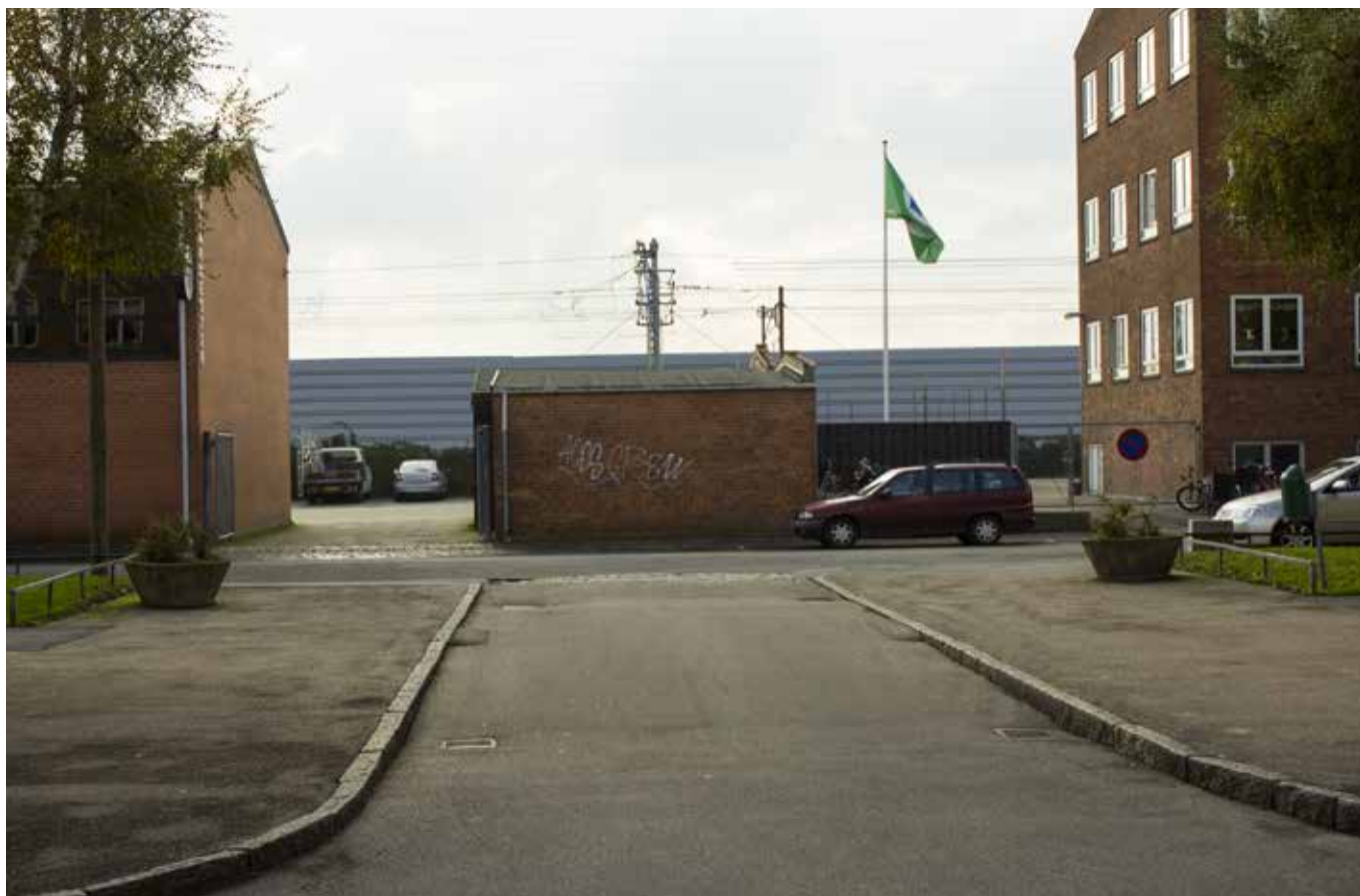
Figur 21 Punkt 5. Udsigt mod syd fra Höfðingsvej i 0-alternativet. Her ses den forhøjede støjskærm.
