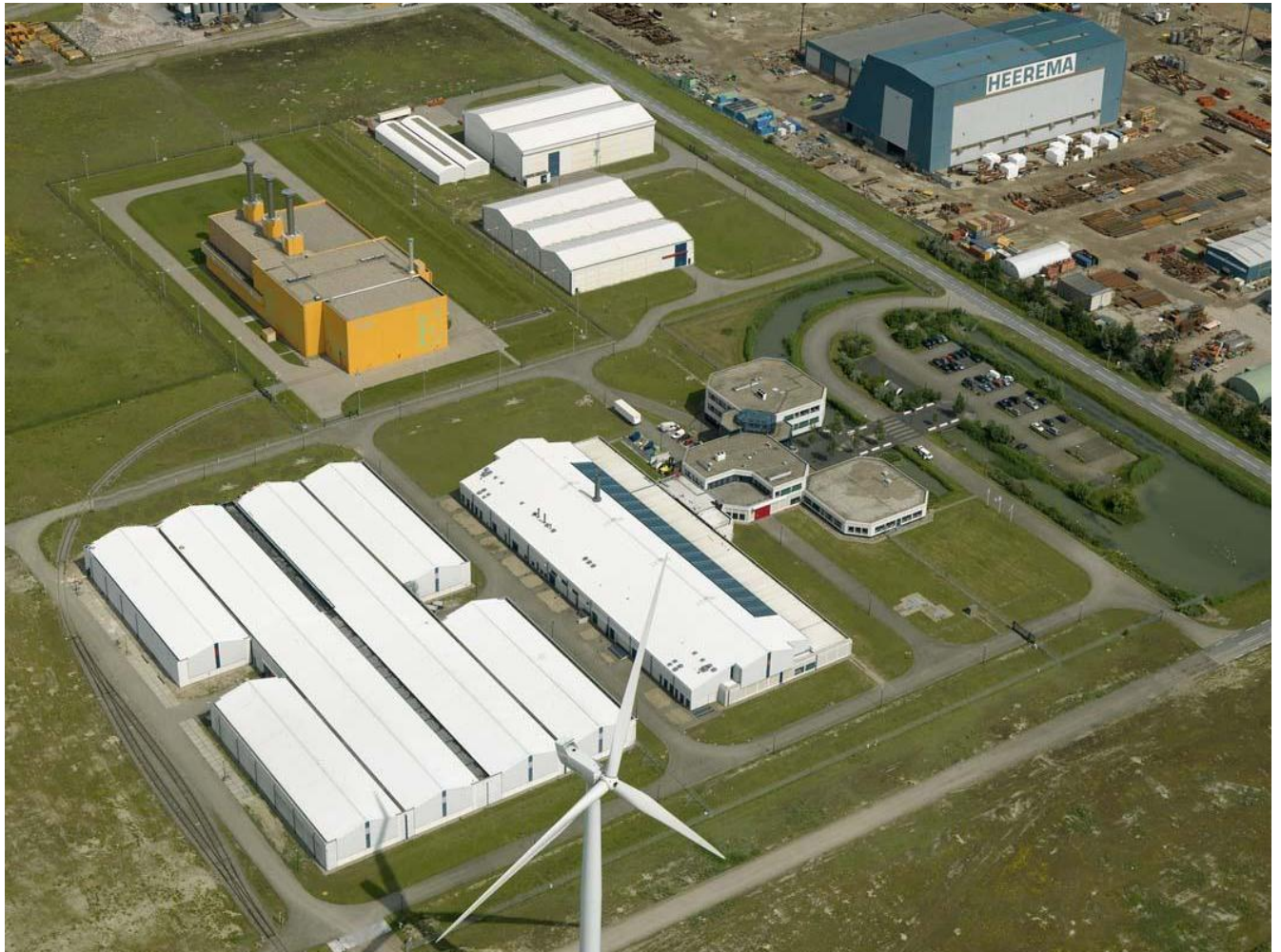
Lageret er opbygget med adskilte bygninger for forskellige typer affald: Forbundne bygninger til lav- og mellemaktivt affald (hvide på foto) og en bygning for højaktivt affald (orange). (Fra COVRA's hjemmeside).
