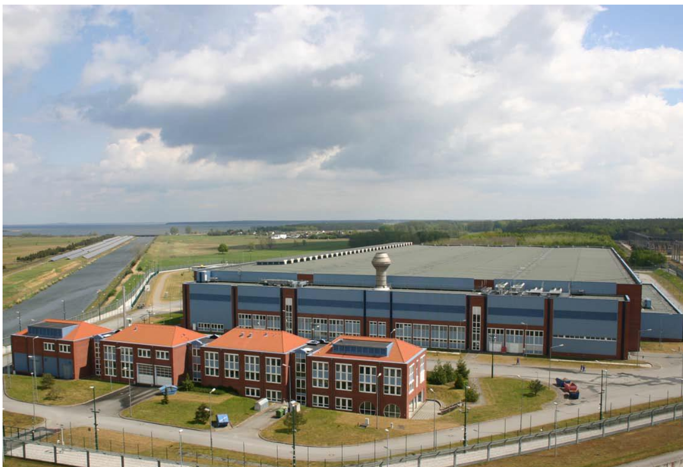
Mellemlager Nord set fra syd mod Østersøen omgivet af dobbelt sikringshegn.
