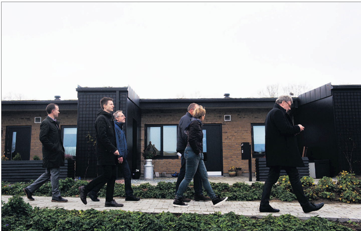
På vej hen mod solcelleanlægget i Danbos afdeling Tjørning passerede politikerne 40 rækkehuse, der alle var forsynet med grønne tage. De isolerer bygningen mod opvarmning om sommeren og afkøling om vinteren. Foto: Timo Battefeld
