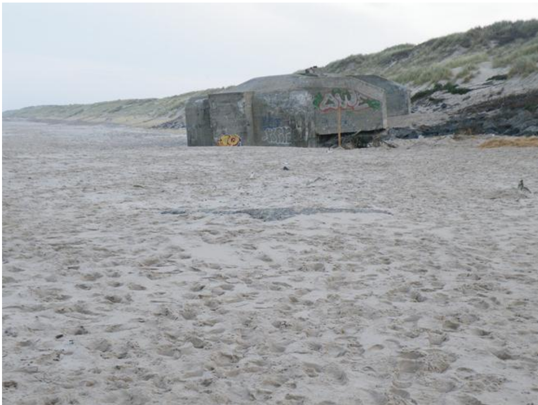
Søndervig 1. november 2012 efter trykudligning i april 2012. Bunkerne er nu på vej til at blive dækket ned i sand, som vi også har set ved Skodbjerge.
