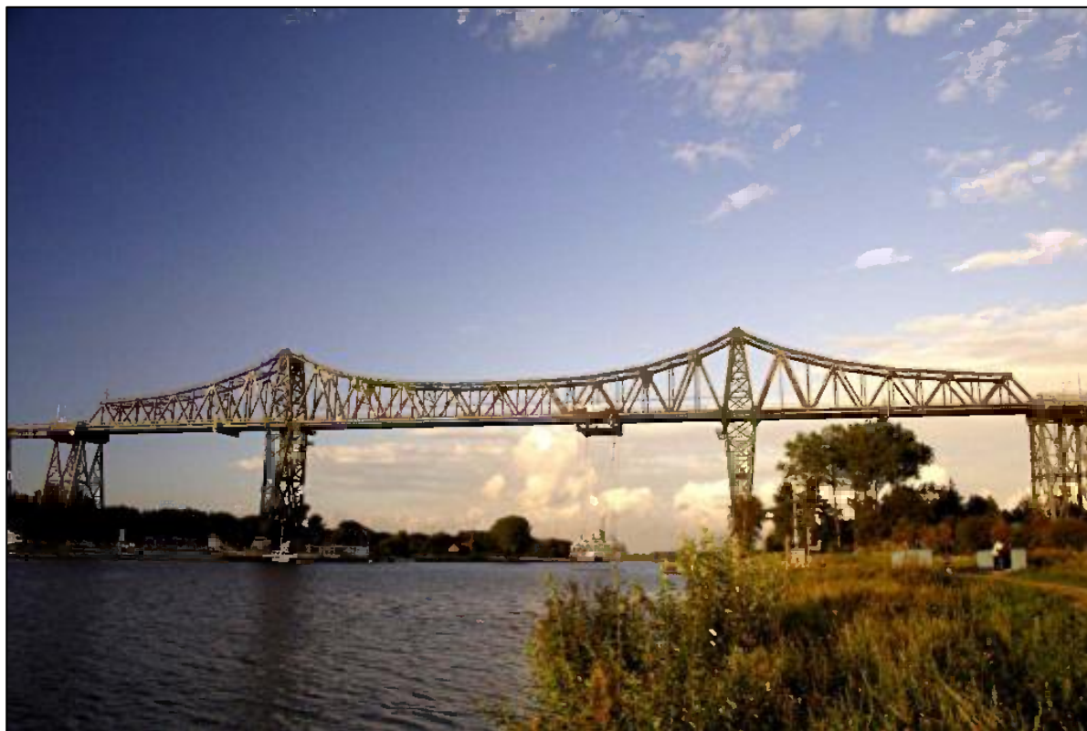
Figur 14.8 – Jernbanebroen med underhængende svævebane oprindeligt benyttet af biler ved Rendsburg. 29
