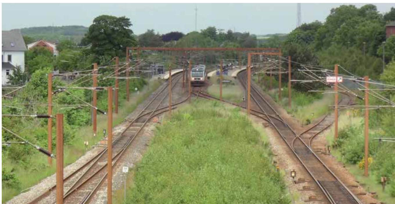
Billede af Lunderskov station, der allerede er elektrificeret
