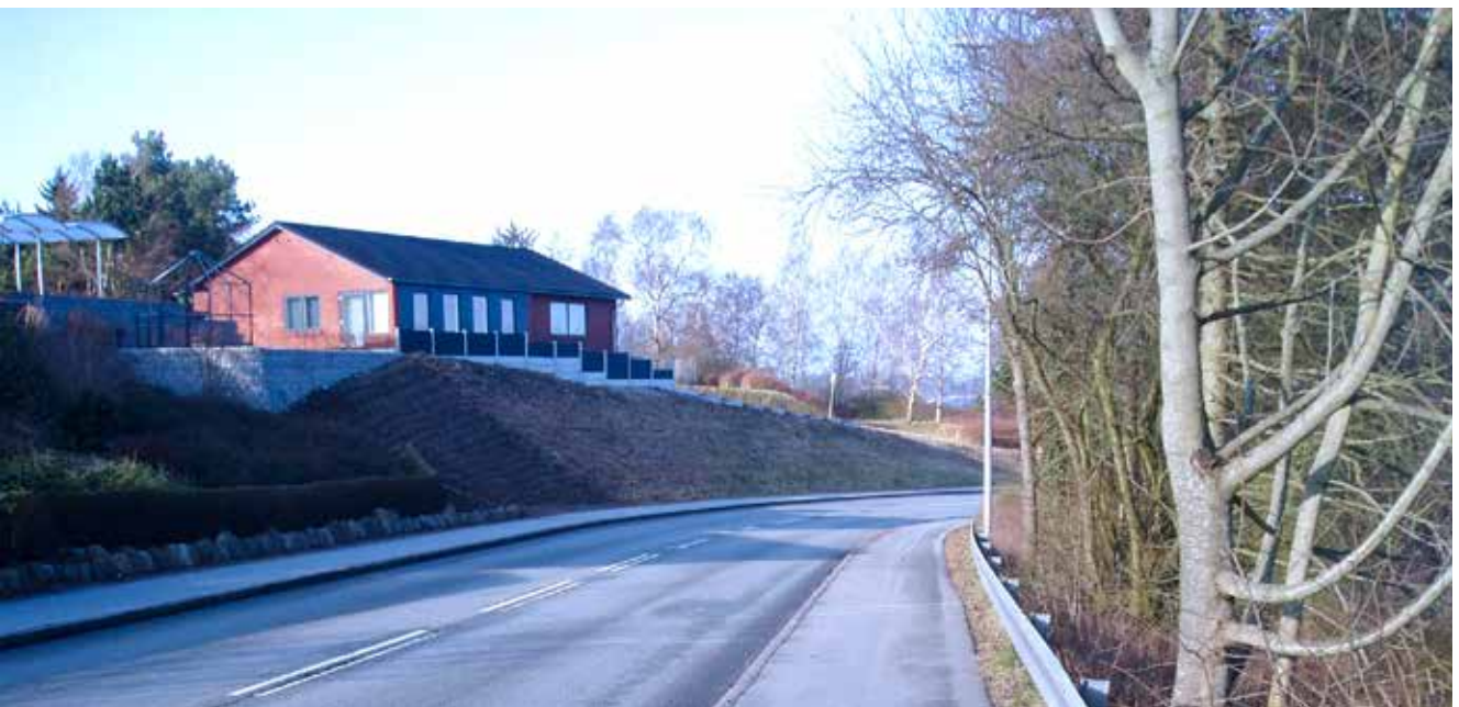
FIGUR 8 Rute 555 umiddelbart nord for Klostergade på delstrækning 2.
