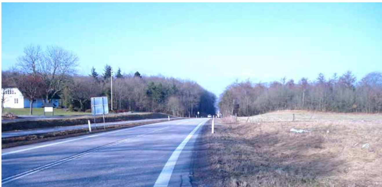
FIGUR 4 Strækningen umiddelbart nord for krydset ved Hobrovej / Randersvej.
