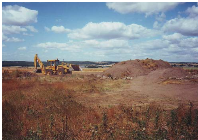
Fig. 12: Gravemaskine i færd med genopførelse af Eshøj III - Kajs Høj.
