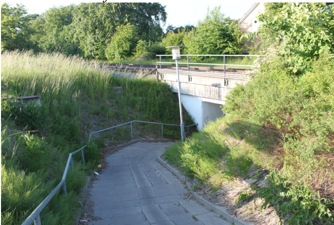
Nedgang til tunnel fra forplads (vestsiden).
