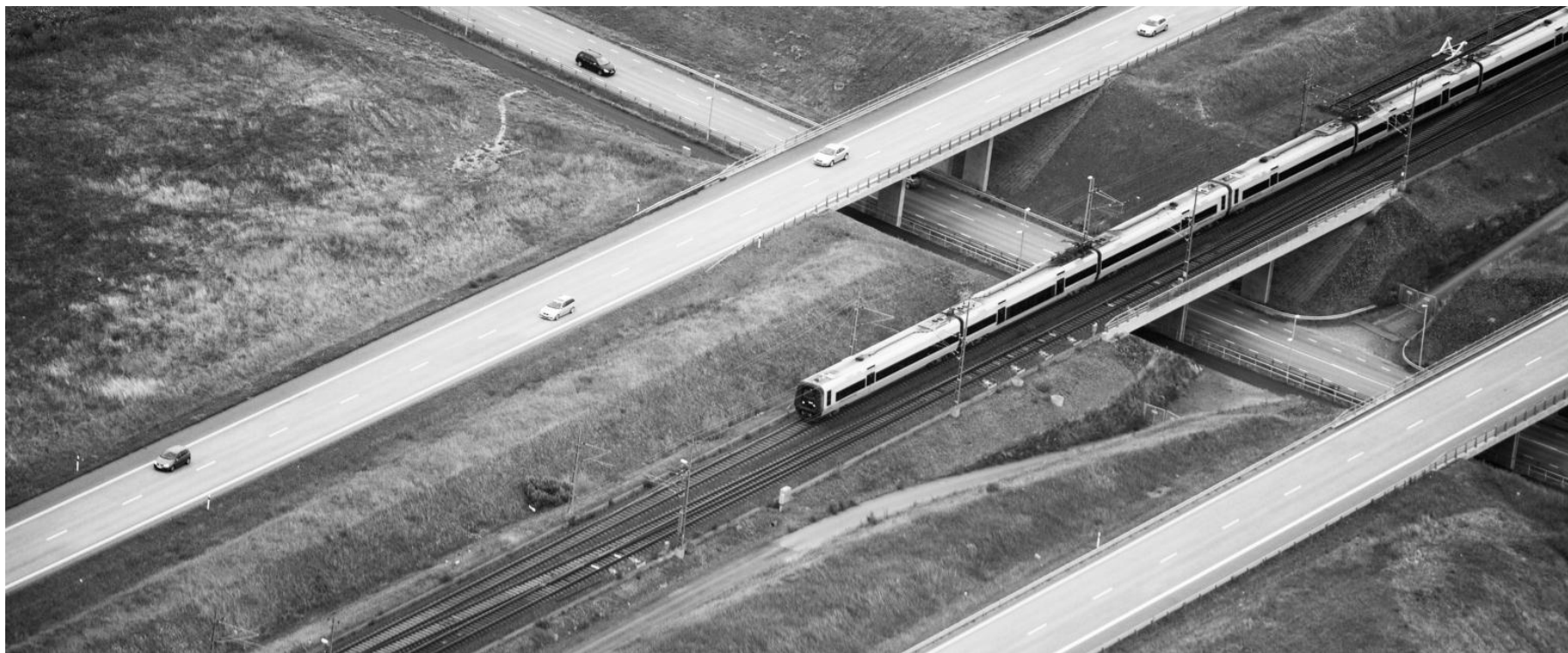
Figur 10. Eksempel på anlæg af jernbane i fælles transportkorridor med motorvej (Øresundsforbindelsens landanlæg)
