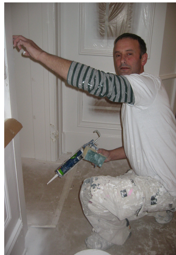
LARS JENSEN ER EKSPERT I AT SPRAYMALE. HAN VED LIGE, HVORDAN HAN SKAL GØRE, FOR AT MALERSKYEN LANDER HELT RIGTIG. "LAGET MÅ IKKE BLIVE FOR TYKT, FOR SÅ LØBER MALINGEN," FORKLARER HAN. MEN INDEN HAN KAN SPRAYE, ER DER FØRST EN MASSE FORBEREDENDE ARBEJDE, DER SKAL KLARES..
