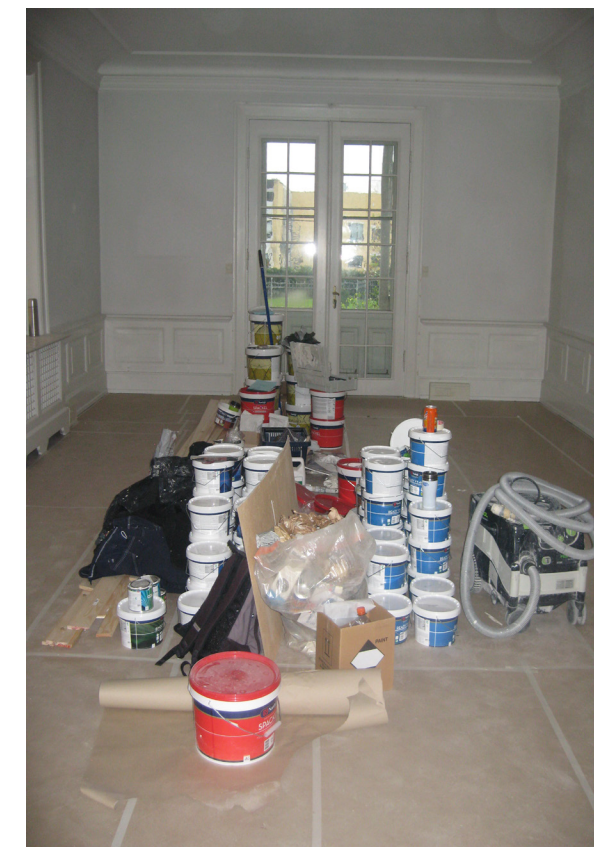
LARS JENSEN ER EKSPERT I AT SPRAYMALE. HAN VED LIGE, HVORDAN HAN SKAL GØRE, FOR AT MALERSKYEN LANDER HELT RIGTIG. "LAGET MÅ IKKE BLIVE FOR TYKT, FOR SÅ LØBER MALINGEN," FORKLARER HAN. MEN INDEN HAN KAN SPRAYE, ER DER FØRST EN MASSE FORBEREDENDE ARBEJDE, DER SKAL KLARES..
