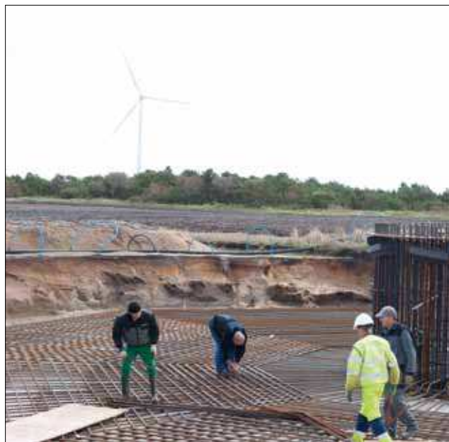
Foto 3.3 Binding af fundament.
