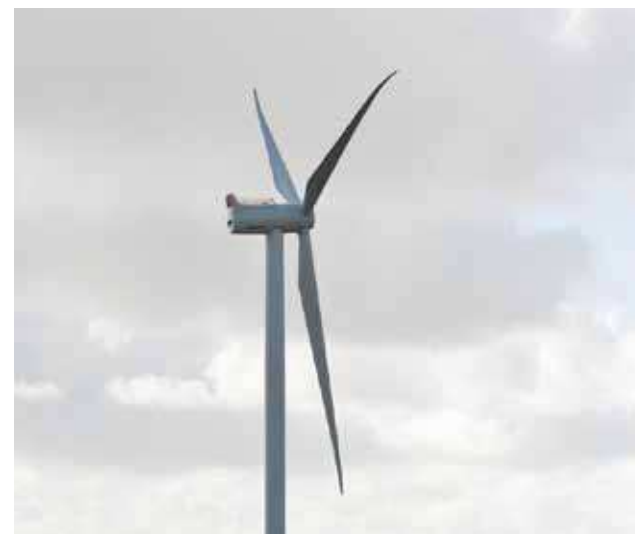
Foto 3.2 Møllehus på en gearløs Siemens vindmølle med 113 meter rotor. Tårnet er placeret midt på møllehuset. Det ses her tydeligt, at vingerne bøjer i spidserne, og toppen ikke er i water, men sænket bagud.
