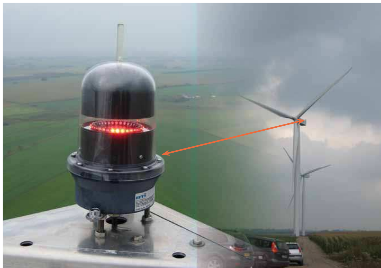
Foto 5.27 Lysafmærkning for flysikkerhed.
