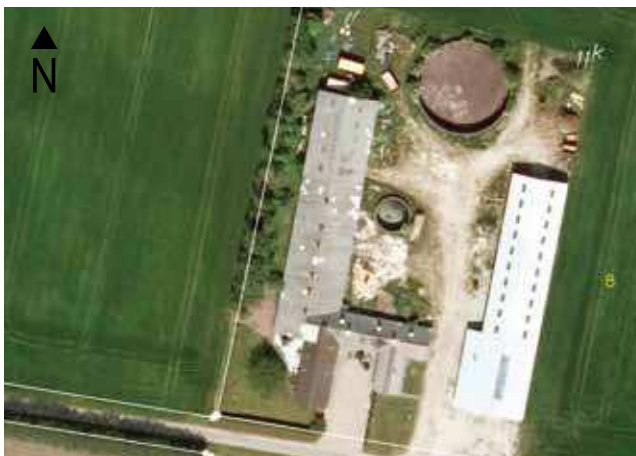
Luftfoto 5.8 Nabobolig 8, Egebjergvej 10.
