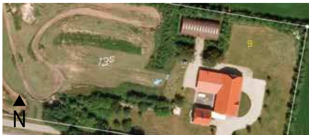
Luftfoto 5.9 Nabobolig 9, Egebjergvej 12.
