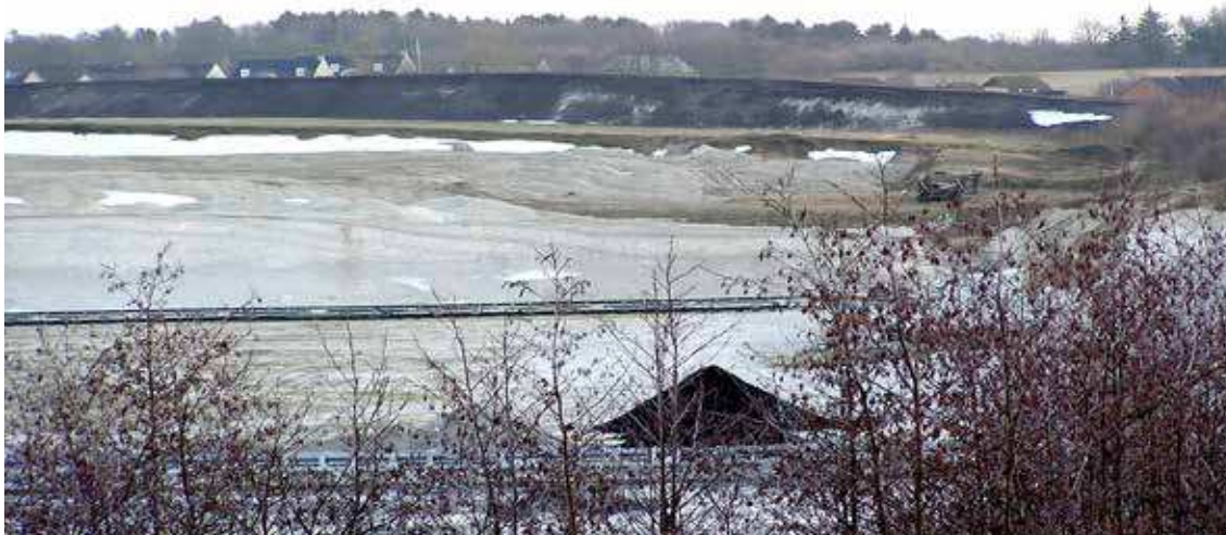
Etablering af støjvold i kridtgraven ved Øster Uttrup
