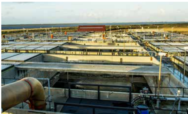
Det store rensningsanlæg blev taget i brug i 1988 og er en forudsætning for driften af produktionsanlægget.
