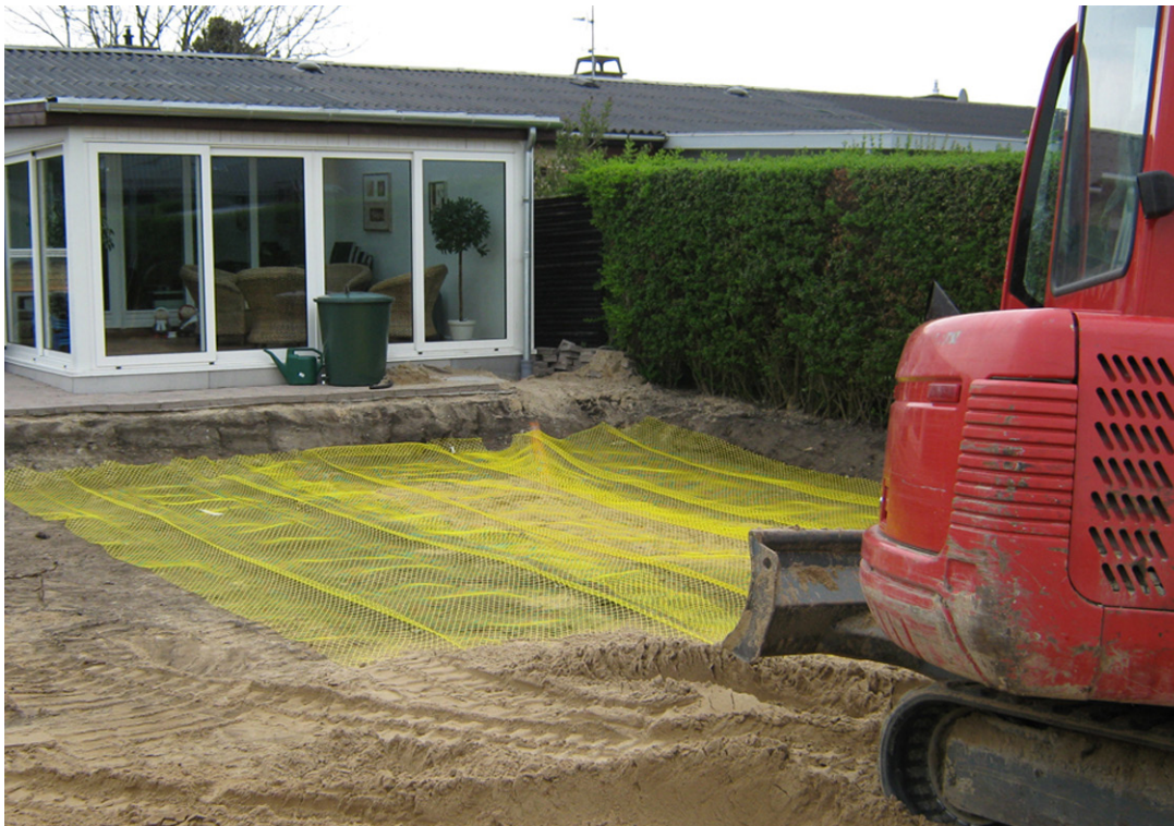
Forurenet jord i overfladen graves op. Det gule net viser, hvor grænsen til den dybere-liggende forurenede jord er.
