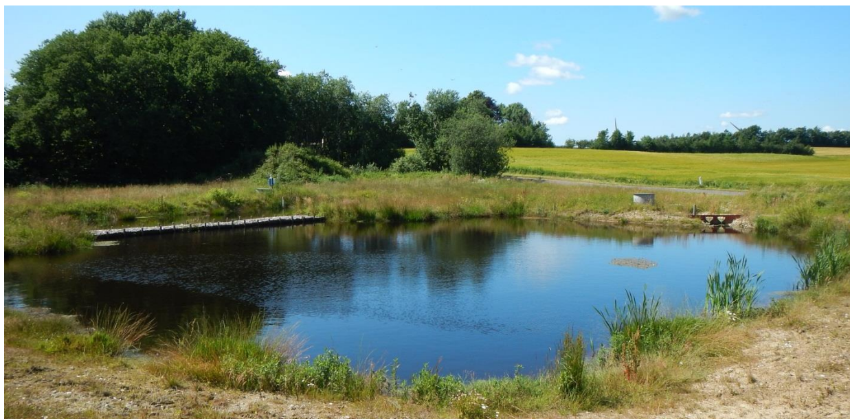
Minivådområde i et tilløb til Åkær Å. Næringsstofferne fra drænvandet i området tilbageholdes og omdannes.
