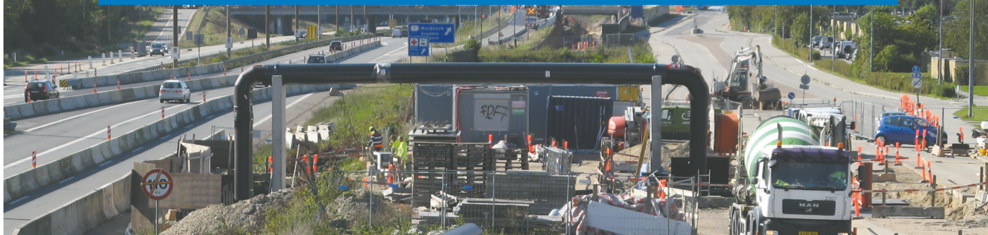
Umiddelbart til højre for den nye rørbro, gemmer den nye station sig 8 meter under vejen
