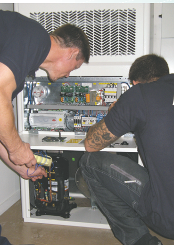
Køleteknikere fra leverandøren Aircold lægger sidste hånd på monteringen af det nye frikølingsanlæg.
