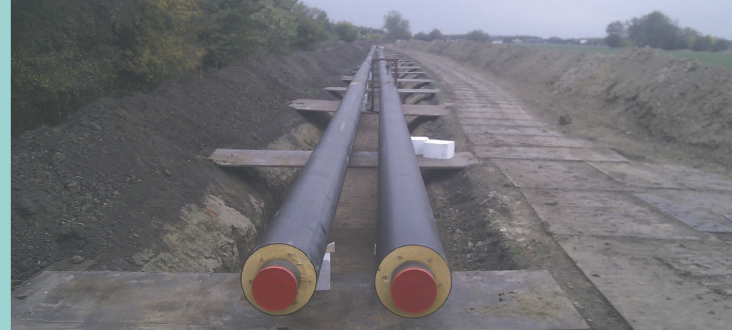
Anlægsarbejdet til den 20 km lange ledning er blandt andet startet i Køge mellem Københavnsvej og Køgebugtmotorvejen. FOTO: Henning Lambertsen.
