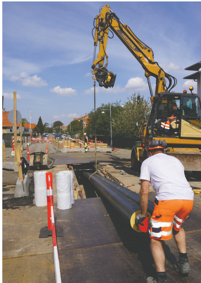
Fjernvarmerør lægges i det udgravede tracé på Sofielundsvej i forbindelse med krydsning af Hovedvejen. FOTO: Glostrup Forsyning
