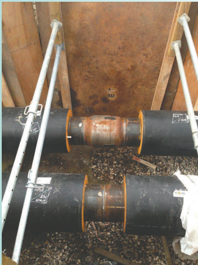
Ekspansionsmuffen varmes via fjernvarmevandet, hvis typiske driftstemperatur er 85 °C. Derefter er muffen klar til at blive svejset, hullet lukkes og vejen reetableres hurtigst muligt. FOTO: Per Lundberg
