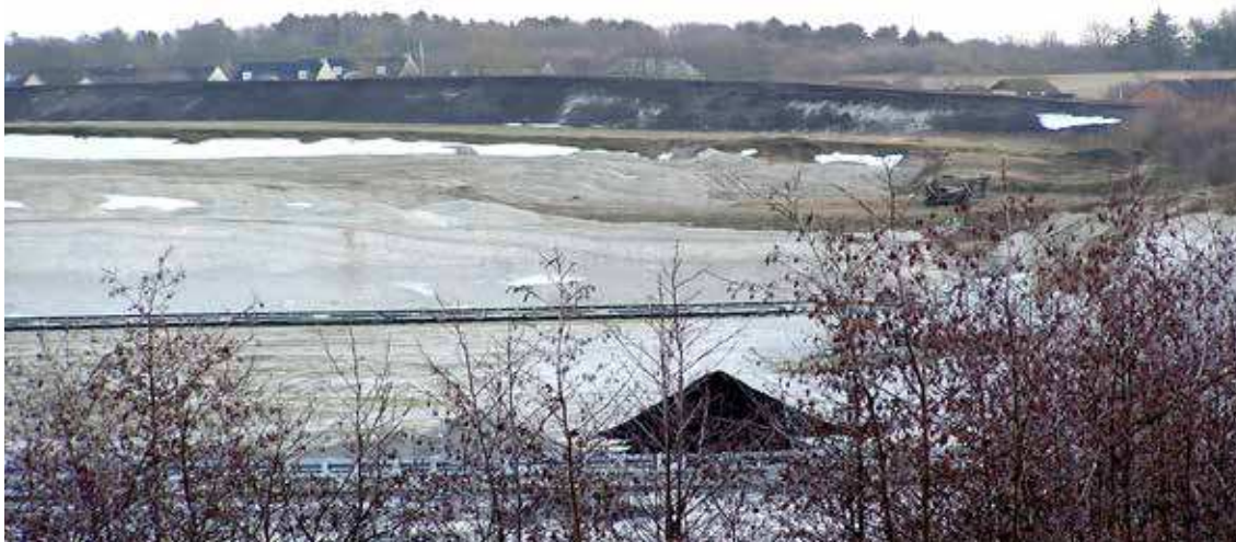
Etablering af støjvold i kridtgraven ved Øster Uttrup
