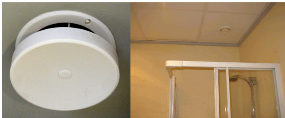
Foto 1 Udsugningstype til mekanisk ventilation
