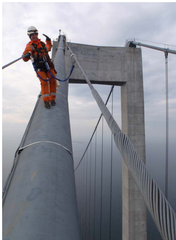
FORCE Technology er her ved at måle boltspændinger ved hjælp af ultralyd på kaberne på Storebæltsbroen.
