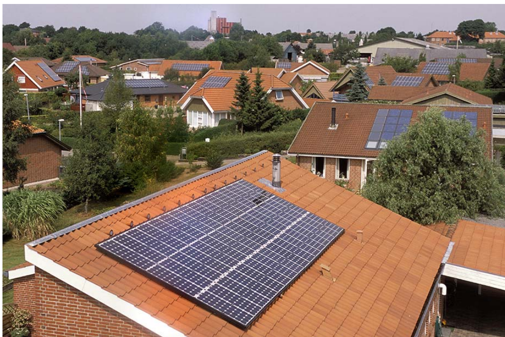
Udbygningen af små husstandsbaseerede solcelleanlæg begyndte for alvor at tage fart i foråret 2012.
